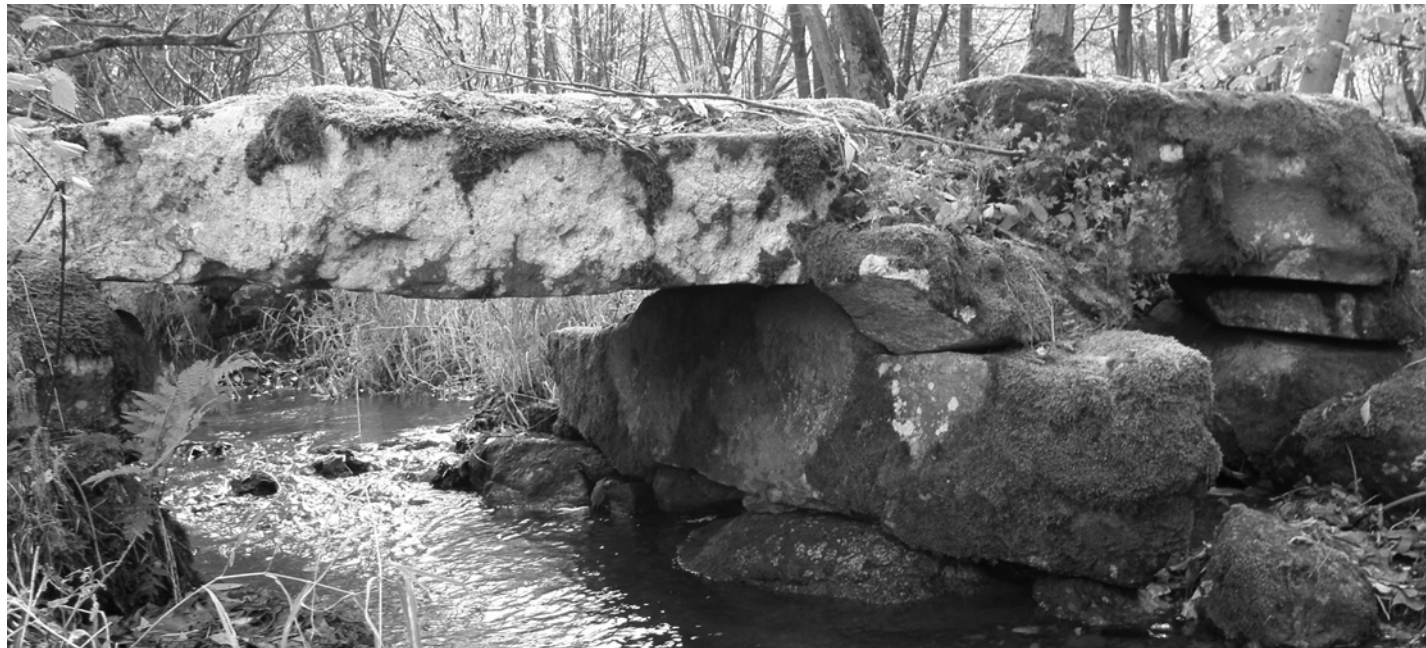
Der Magistersteg: Große Basaltplatten auf mächtigen Basaltbrocken bilden den Steg über den Wannbach.
